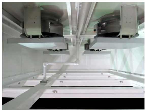
INSIDE FAN POWERED PLENUM MODULE
